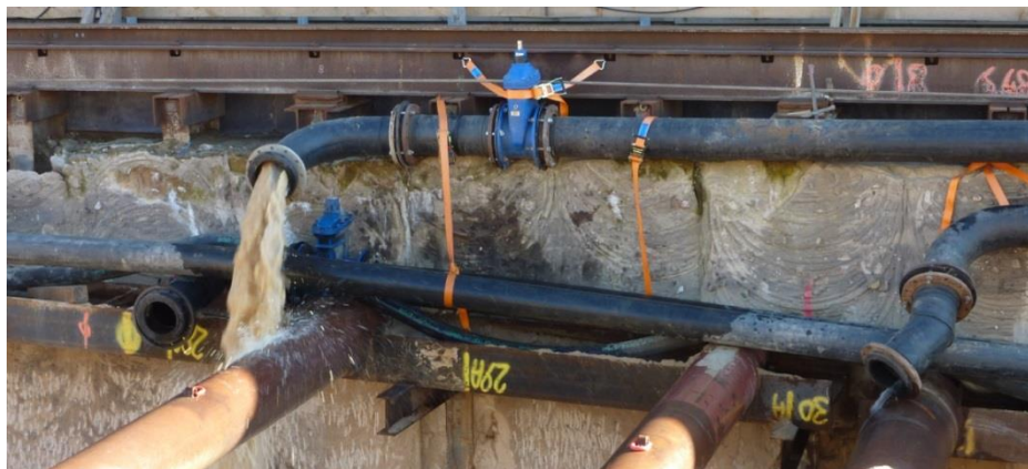
Afb. 5: Zand opzuigen en per buis verplaatsen i.p.v. per vrachtwagen zodat transportbewegingen afnemen.
