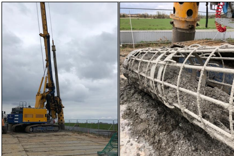
Voorbeeldfoto's boorsituatie/wapeningskorf met beton
